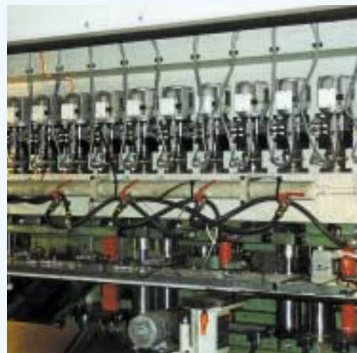
⑩ Sähkömekaaniset kääntö- ja vetokiinnittimet transferpuristimessa
