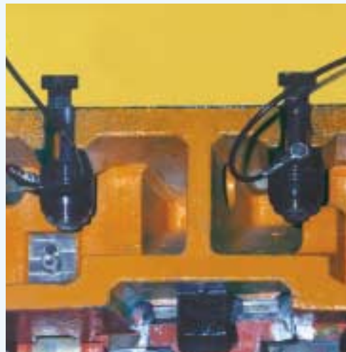
④ Puskiin asennetut reikämäntäsyllinterit
